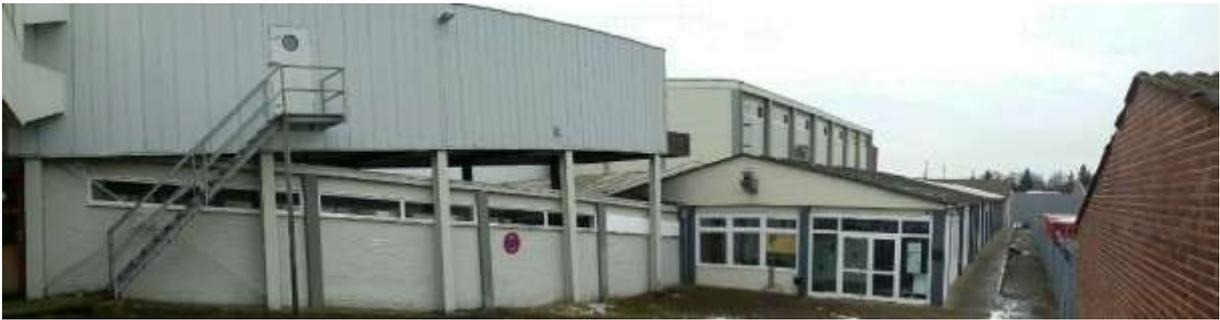
Häuser-Hallenkomplex im Norden mit Zink- und Dachpappdach, Metallverkleidungen, tws. Eternit, Mauerwerk i.d.R. gut erhalten und dicht, keine größeren Spalten oder Höhlen vorhanden. Fledermäuse oder Nischenbrüter sind unter kleinen Spalten z.B. im Pappdach nicht auszuschließen.
