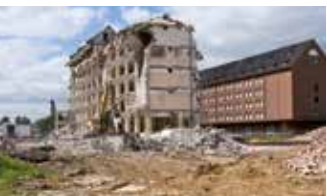
Abriss eines Speichers
