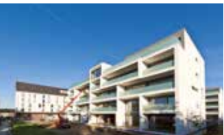
Neubau von Wohnhäusern
