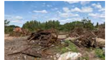
Abtragen der Schienen
