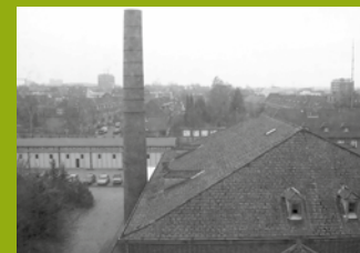
Heeresbäckerei vor der Sanierung
