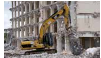
Abtragen des Speicherbaues
