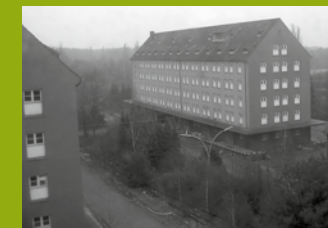
Speichergebäude vor der Sanierung
