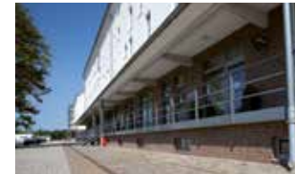
Erhaltung der alten Gleisschienen vor den beiden Speicherbauten
