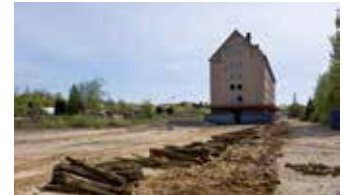
Abtragen der Gleishölzer
