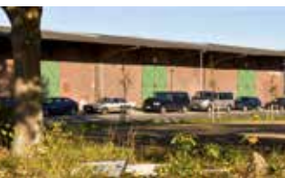
Technisches Hilfswerk mit sanierten Rolltoren
