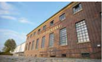
Sanierung der ehemaligen Heeresbäckerei
