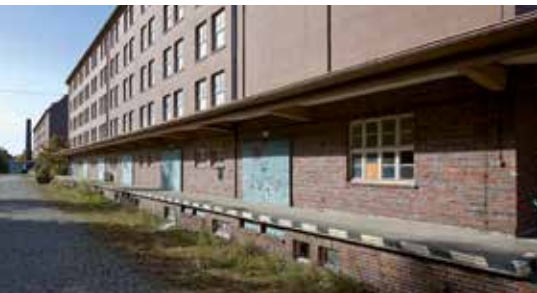
Alte Laderampe am Speichergebäude
