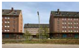
Speichergebäude vor Sanierung und Abriss
