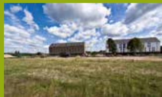
Saniertes und unsaniertes Speicher
