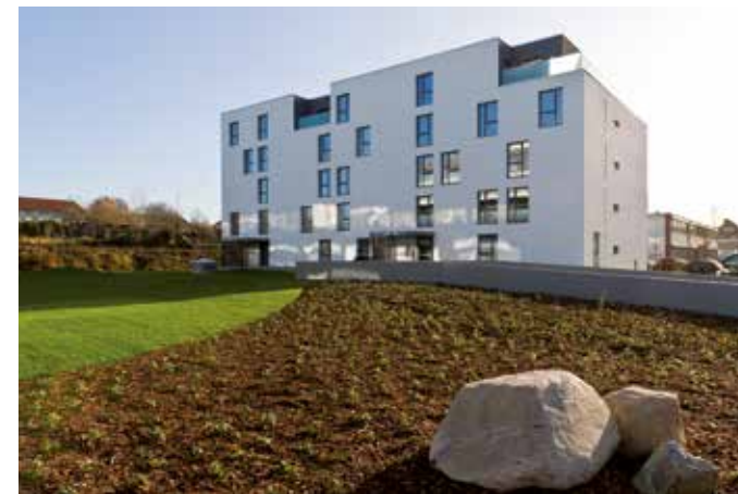
Fertiges Wohnhaus hinter Speicher 2
