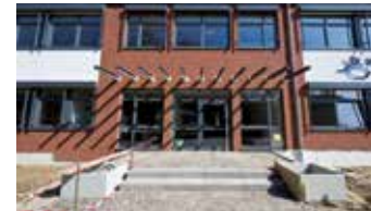
Neubau des Schulgebäudes
