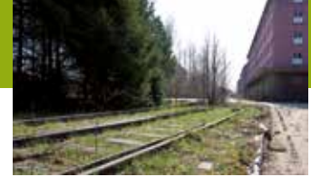
Gleise im Zustand vor der Sanierung
