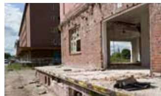
Entkernung der Speichergebäude
