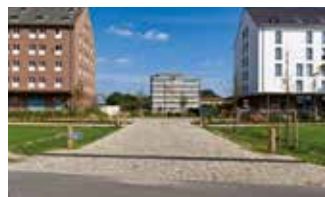
Unsanierter und sanierter Speicher 1 mit Neubau
