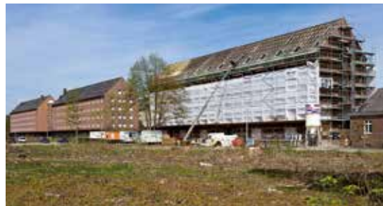
Sanierung des ersten Speichergebäudes
