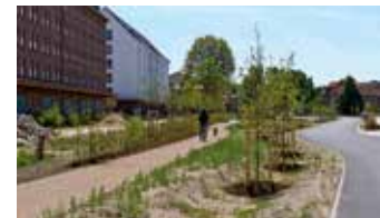
Saniertes und unsaniertes Speichergebäude
