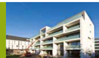
Fertiges Wohnhaus hinter Speicher 1
