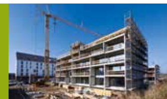
Rohbau Wohnhaus hinter Speicher 1
