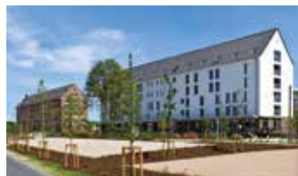
Speichergebäude mit neu angelegten Parkplätzen und Bepflanzung
