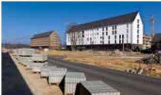
Anlegen der Infrastruktur
