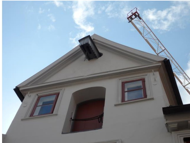
Fotos: historische Aufzugsanlage mit Windenrad Heiligengeiststraße 38
